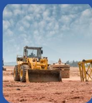
NO.3 施工场地
