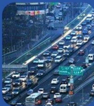
NO.5 城市道路
