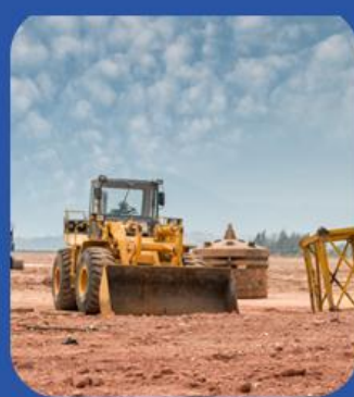
NO.3 施工场地
