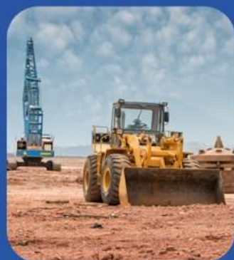
NO.3 施工场地
