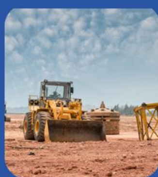
NO.3 施工场地
