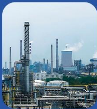
NO.2 建筑工程
