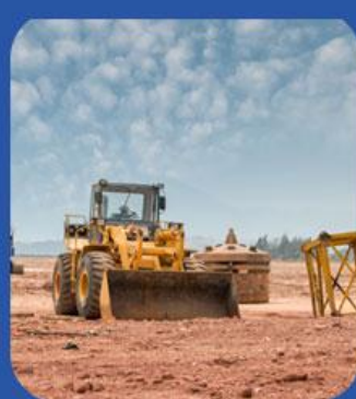
NO.3 施工场地
