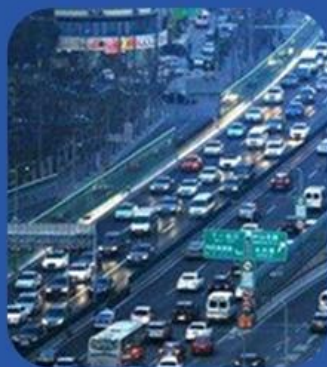
NO.5 城市道路
