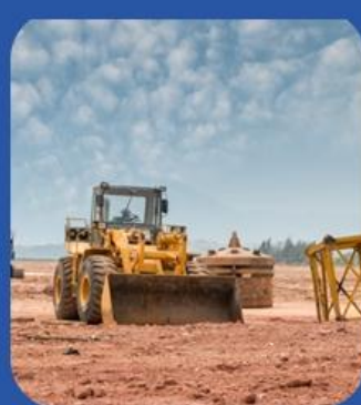
NO.3 施工场地
