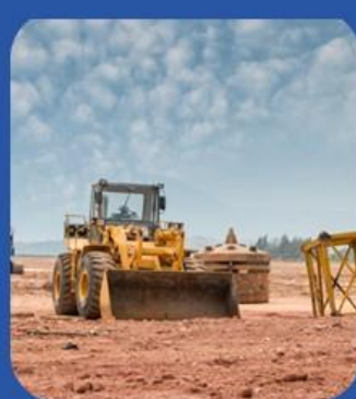
NO.3 施工场地
