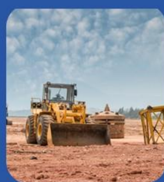
NO.3 施工场地
