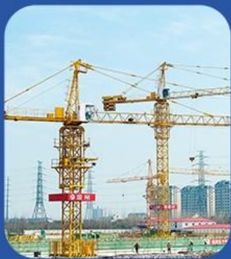
NO.1 建筑工程
